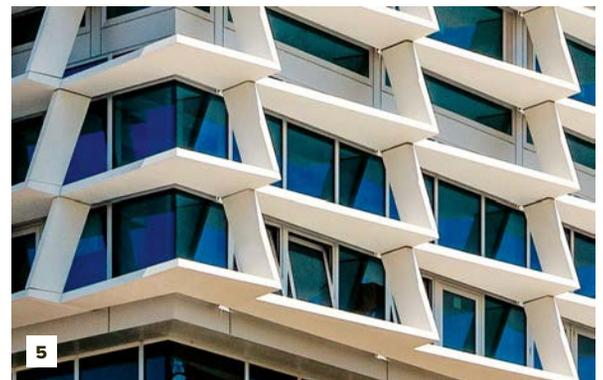
leistungsbeton, sie wurden in hoher Stückzahl komplett in anspruchsvollem Sichtbeton ausgeführt. Der in Spezialschalungen mit geschliffenen Chromstahlblechen hergestellte Beton muss frostbeständig sein und dem Tausalz widerstehen. Damit die Elemente das Maximalgewicht von 790 kg nicht überschreiten, besteht der Füllkörper aus Multipor. Um eine rationelle, reibungslose Montage sicherzustellen, mussten die Elemente mit einer Toleranz von +/- 2 mm ausgeführt werden.
